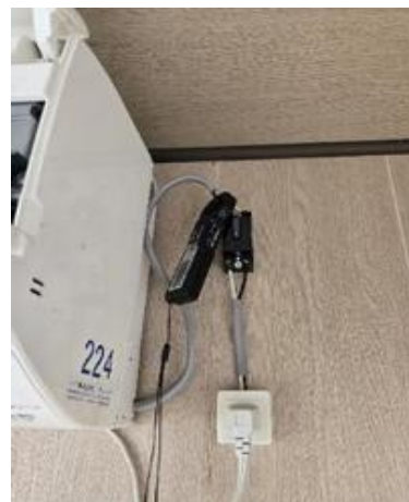
電力測定器を取り付け
