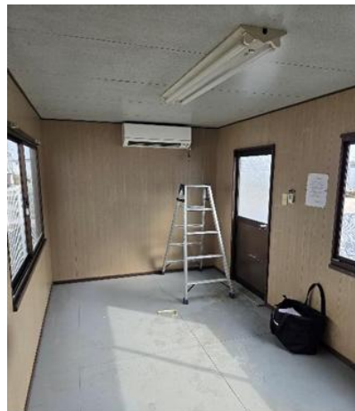
室内に壁掛けエアコンを設置
