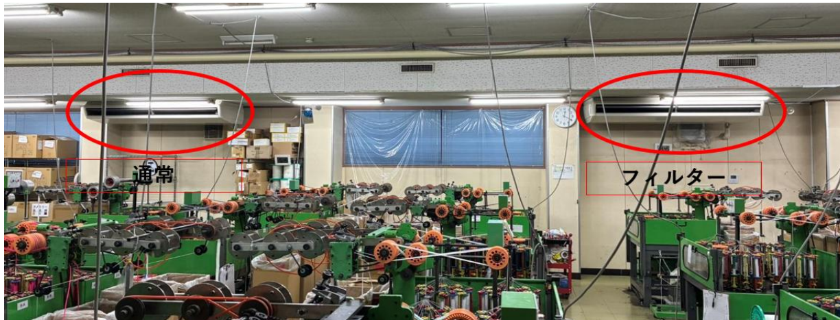
部屋の天吊りエアコンにエアエコ（右側）を設置 左側エアコンは設置無し
