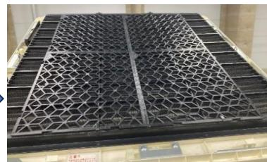
\* フィルターの清掃時、カバーを下すとエアエコ®が落ちることを防ぐために、3cm程度にカットした両面テープをエアエコ®の四隅に貼り、フィルターと貼り付けることで固定することができます。
